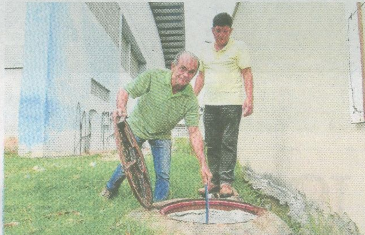
Amadeu Botelho (de verde) mostra a ligação de esgoto
