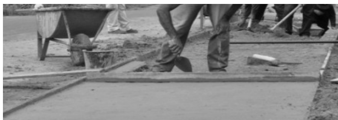
Figura 02: Pedreiro executando a construção de parte de uma Calçada Cidadã
